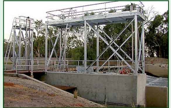
The new Deelder Fishlock at Balranald Weir
